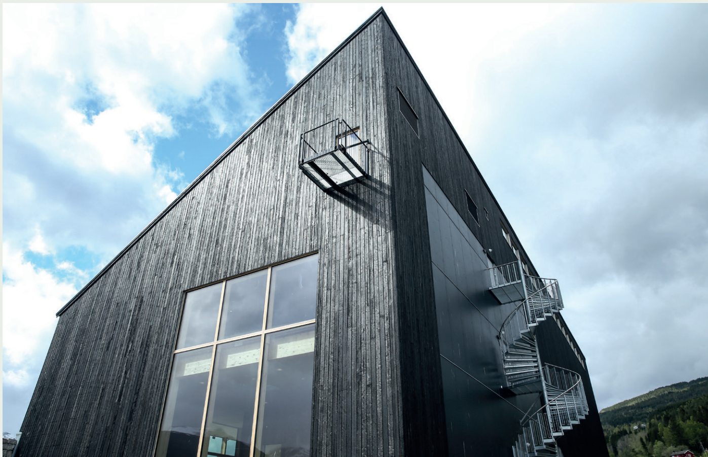
Fasaden på bygget er kledd med brent kledning.
