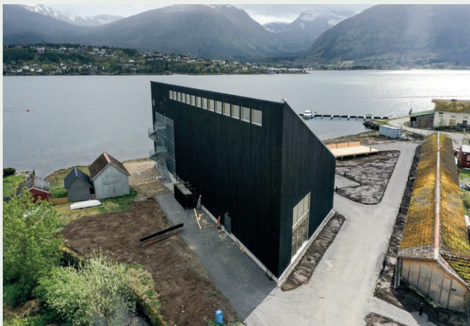
Bygget til Holvikjekta sett fra nordvest.
